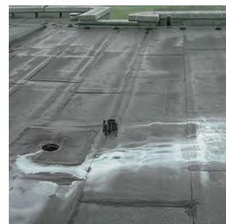
Applicazioni tipiche sono, ad esempio, l'esame di tetti piani per rilevare un difetto di tenuta mediante il test del colorante.
