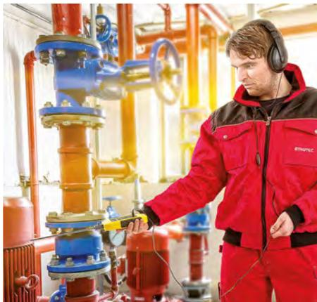
Sulle pompe e sulle altre macchine da lavoro è possibile constatare tempestivamente i segni di usura, grazie alla sonda per le vibrazioni meccaniche.
