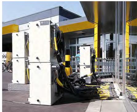
Le porte attraversate da tubi con PlanoPT possono restare bloccate in modo che i collegamenti non debbano essere smontati per la chiusura notturna e che i condizionatori possano rimanere in funzione 24 ore su 24, se necessario.
