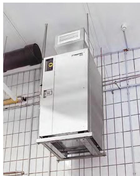
Le unità a pavimento più grandi della Serie DH presentano dal lato di scarico un attacco per canale rettangolare per la facile integrazione nei sistemi di ventilazione presenti. Come optional si possono collegare inoltre tubi flessibili per ventilatori nonché strutture speciali come ad es. calotte di ventilazione, realizzabili su richiesta.
