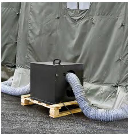
Con la Drybox è possibile impiegare i deumidificatori ad adsorbimento anche nelle aree esterne, per mantenere asciutti senza disturbi gli ambienti interni degli alloggi o dei magazzini merci, utilizzando il ricambio dell'aria.
